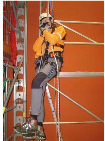
Abb. 4 Anwendung der Prusikschlinge
